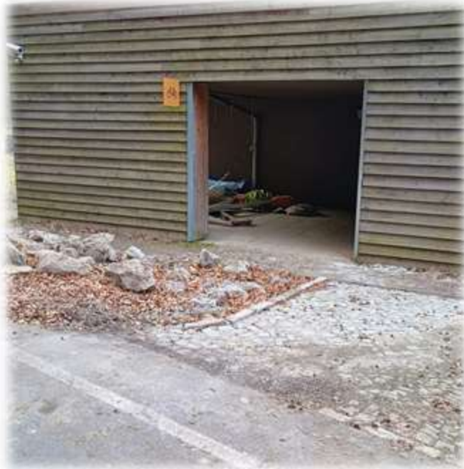
Vyčištěné kameny u úschovny kol
