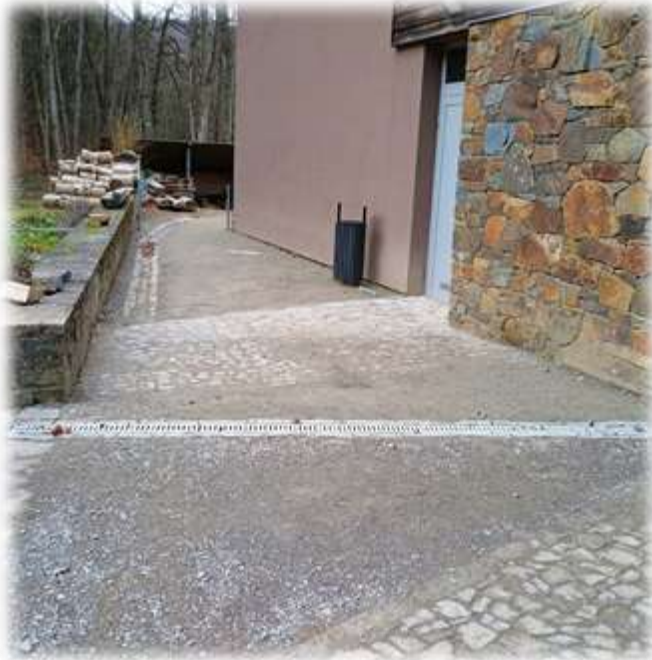
Opravená cesta u veřejných záchodů
