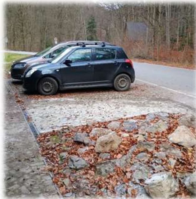
Opravená cesta u garáže
