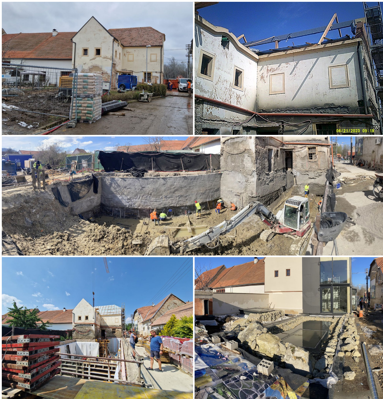
Fotodokumentace z průběhu stavby (2023–2024)
