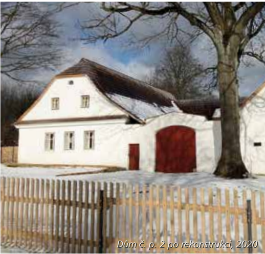
Dům č. p. 2 po rekonstrukci, 2020
